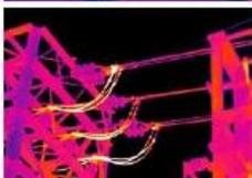
Le stazioni elettriche ad alta tensione tendono a surriscaldarsi prima di smettere di funzionare. Monitorandole continuamente con delle termocamere, è possibile evitare costosi guasti.
