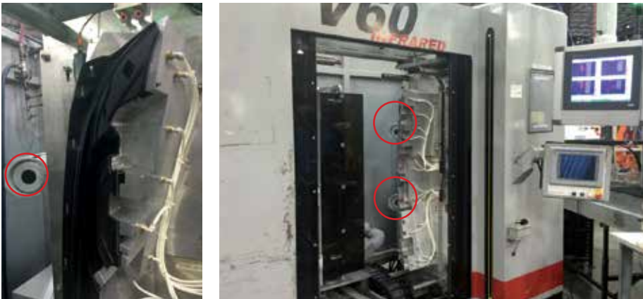
Yanfeng ha commissionato a Emittet Energy l'installazione di quattro termocamere FLIR A315 sulla macchina di saldatura IR, dedicata alla griglia di sbrinamento del parabrezza della Ford Escape.
